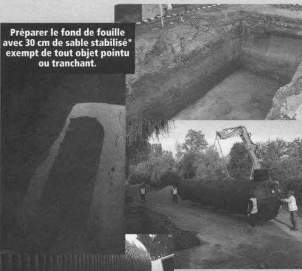
Poser la cuve DP EP de façon parfaitement horizontale sur le fond de fouille en tenant compte du sens de cheminement (entrée/sortie). Le cas échéant, raccorder les cuves constitutives de la cuve DP EP.
