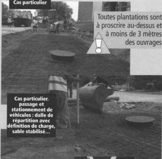
Cas particulier. passage et stationnement de véhicules : dalle de répartition avec définition de charge, sable stabilisé...
