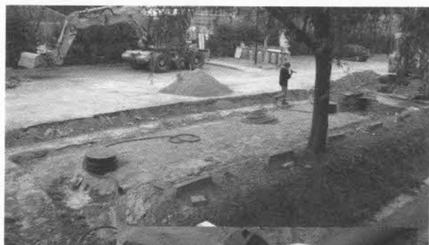
Raccorder les canalisations entre l'habitation et la cuve DP EP (entrée, sortie et ventilation haute) avec une pente comprise entre 2 % et 4 %. Le raccordement des canalisations ne se fait qu'après l'opération de remblayage latéral.
