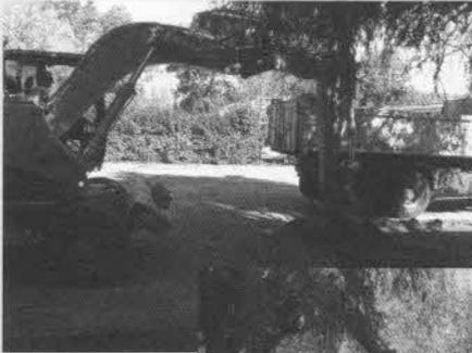
Délimiter la zone d'implantation de la cuve DP EP. Décaper soigneusement. Réaliser les fouilles et évacuer les déblais.
