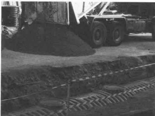
Remblayer latéralement et symétriquement sur une épaisseur de 30 cm en sable stabilisé\* exempt de tout objet pointu ou tranchant. (\* mélange à sec de 1 m<sup>3</sup> de sable avec 200 kg de ciment
